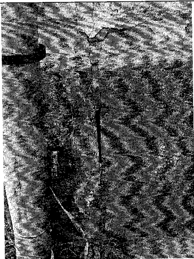
Фото 13-14. Стены. Наличие растрескиваний швов между стеновыми панелями местной потерей герметичности, а также на локальных участках выявлены признаки разрушения покрасочного покрытия наружных стен.
