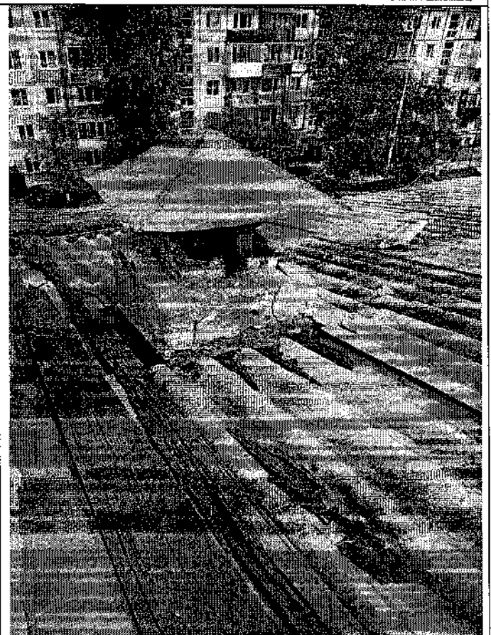
Фото 9-12. Кровля. Трещины и пробоины в покрытии из волнистых асбестоцементных листов. Повреждение (местное разрушение) защитных коньковых элементов и элементов примыкания к выступающим конструкциям. Повреждение оголовка шахты.
