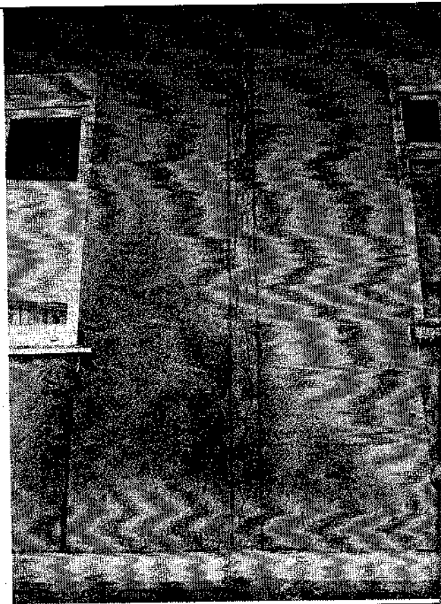
Фото 13-14. Стены. Наличие растрескиваний швов между стеновыми панелями местной потерей герметичности, а также на локальных участках выявлены признаки разрушения покрасочного покрытия наружных стен.
