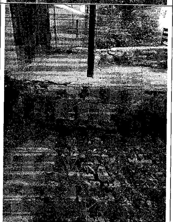
Фото 1-4. Отмостка и крыльца здания. Повреждение отмостки. Вымоины под отмосткой. Разрушение крылец.
