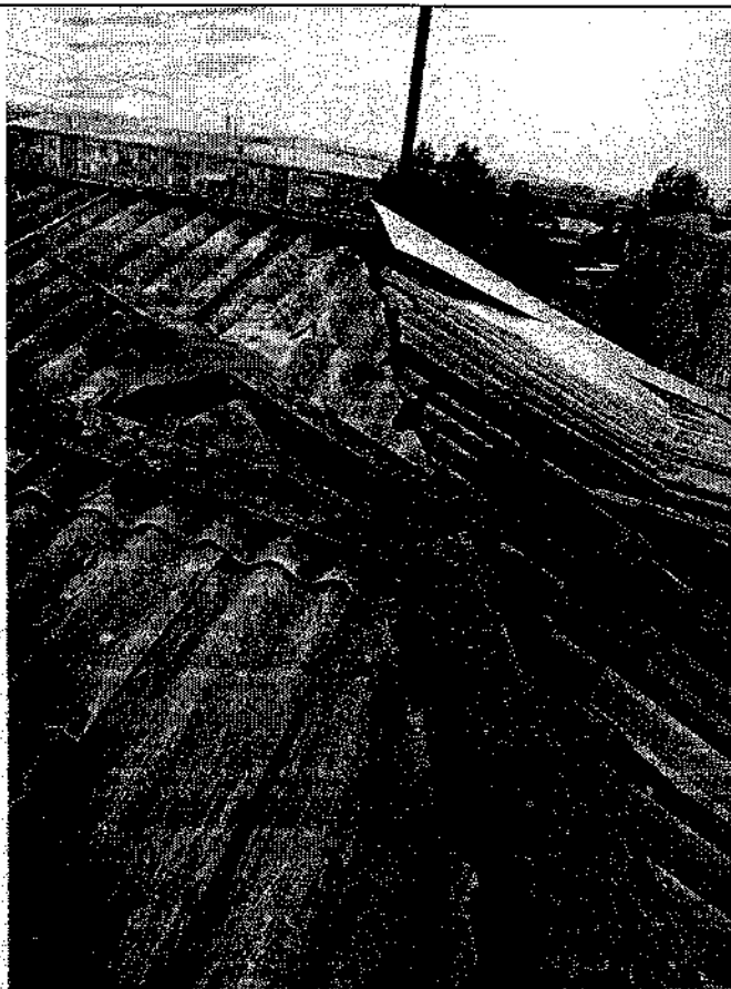
Фото 9-12. Кровля. Трещины и пробоины в покрытии из волнистых асбестоцементных листов. Повреждение (местное разрушение) защитных коньковых элементов и элементов примыкания к выступающим конструкциям. Повреждение оголовка шахты.
